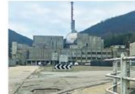
La centrale del Brasimone
